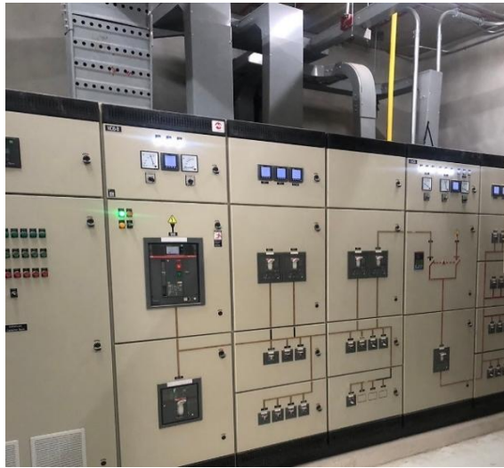
ภาพที่ 32.ระบบควบคุมการจ่ายไฟฟ้า
