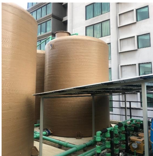
ภาพที่ 11.ถังเก็บน้ำสำรองใช้
